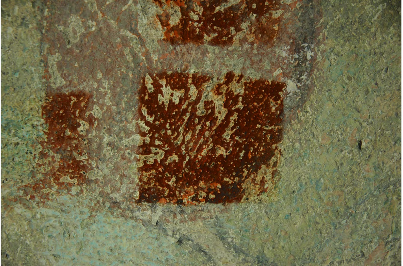
Vom Gipsschleier befreite Stelle: durch die Nachreinigung wird ein kleiner Anteil an Originalsubstanz abgetragen
