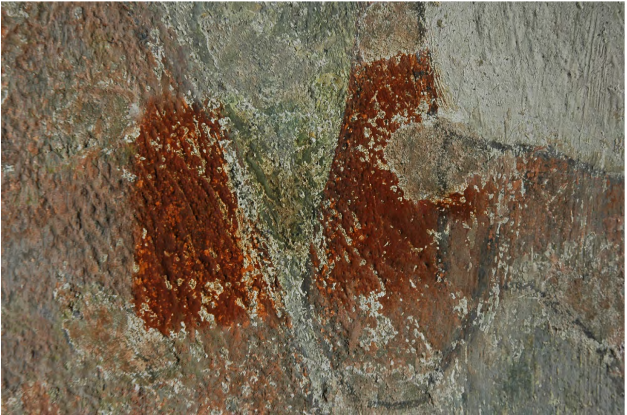
Mit Aerosolen konsolidierter Bereich: die Gipsschleier wurden mit einem weichen Pinsel entfernt.
